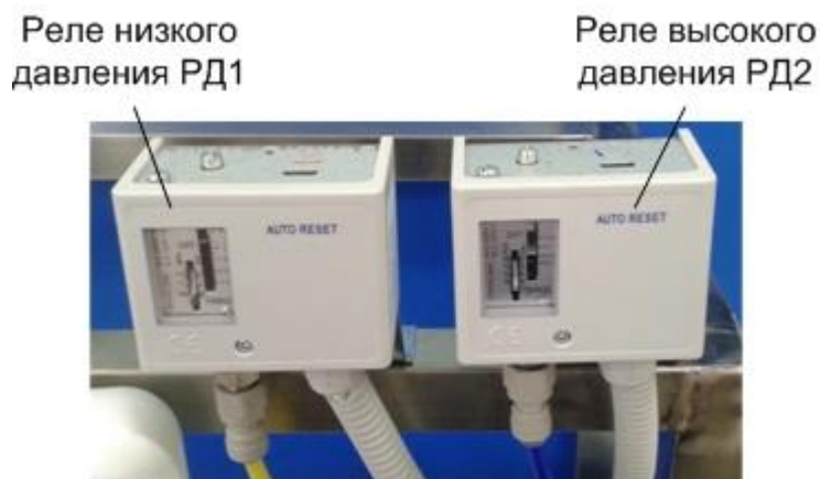
Рис.4 Реле давления.
