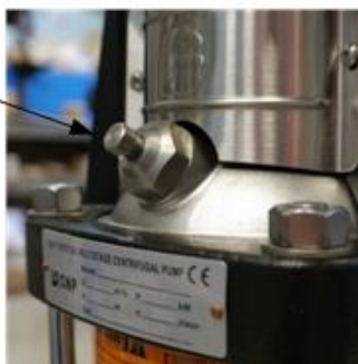
Рис.7 Пробка на насосе для выпуска воздуха.
