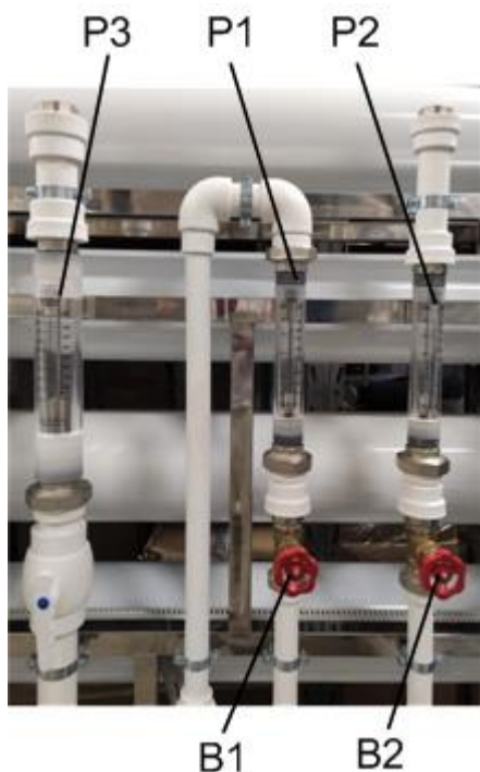
Рис.3 Ротаметры и вентили
