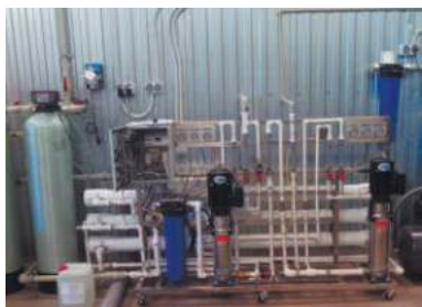
Двухступенчатый обратный осмос производительностью 0,5 м³/ч с предочисткой для подготовки деминерализованной воды для прачечной
