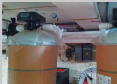
Подготовка воды для заливки льда производительностью 10 м³/ч (обезжелезивание и механическая очистка)
