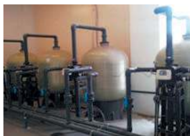
Станция обезжелезивания хозяйственно-питьевого назначения производи- тельностью 2200 м³/сутки
