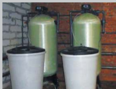
Станция умягчения воды непрерывного действия производительностью 10 м³/ч
