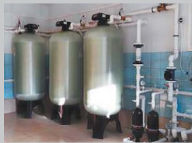
Станция обезжелезивания производительностью 15 м³/ч для рыбоводческой фермы
