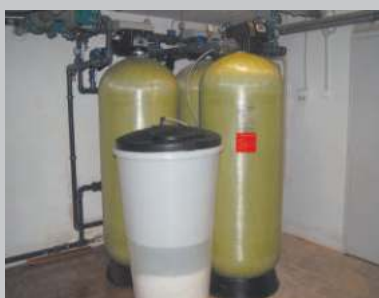
Станция обезжелезивания производительностью 10 м³/ч для элитного многоквартирного дома
