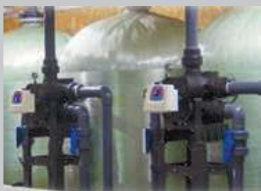
Станция обезжелезивания и деманганции воды хозяйственно-питьевого назначения производительностью 1000 м³/сутки
