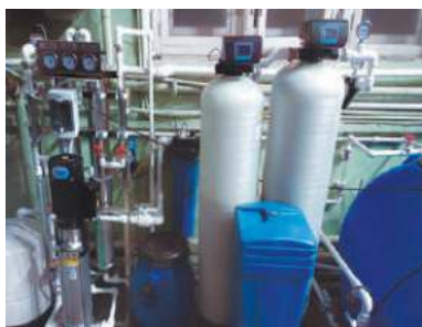
Станция производительностью 0,5 м³/ч для станка гидроабразивной резки, включающая сорбционный и ионообменный фильтры, установку обратного осмоса, блок дозирования реагента
