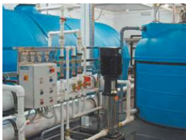
Комплексная станция подготовки воды производительностью 20 м³/ч, включающая обезжелезивание, УФ-обеззараживание и систему обратного осмоса
