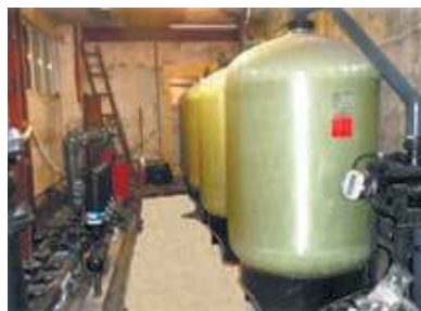
Станция обезжелезивания хозяйственно-питьевого назначения производи- тельностью 2800 м³/сутки
