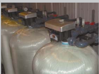
Станция обезжелезивания и обеззараживания воды производительностью 800 м³/сутки для детского оздоровительного лагеря
