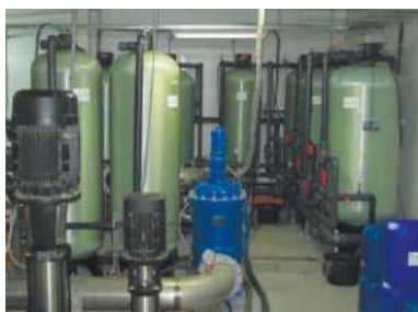
Очистка воды из поверхностного источника производительностью 7 м³/ч для водоснабжения загородного гольф-клуба (реагентная обработка, обезжелезивающие, сорбционные и ионообменные фильтры, а также обеззараживание ультрафиолетом)
